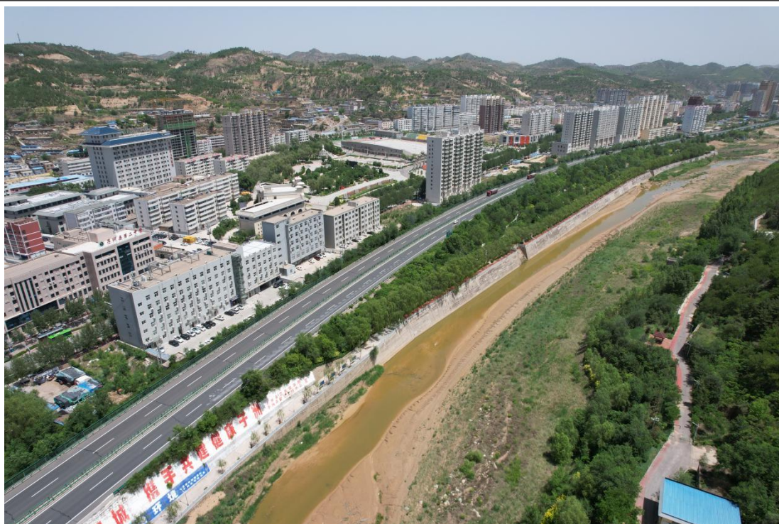
双云观大桥段河道现状
