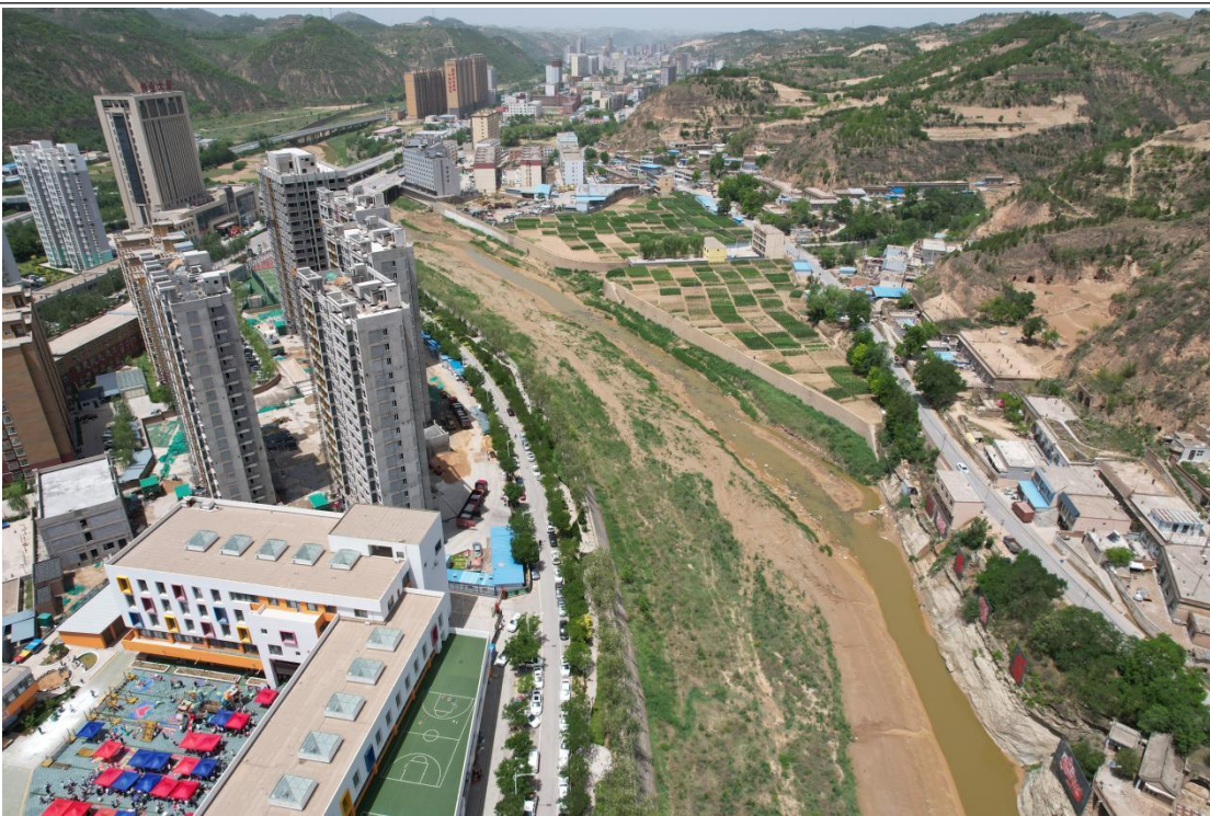
颐和小区段河道现状
