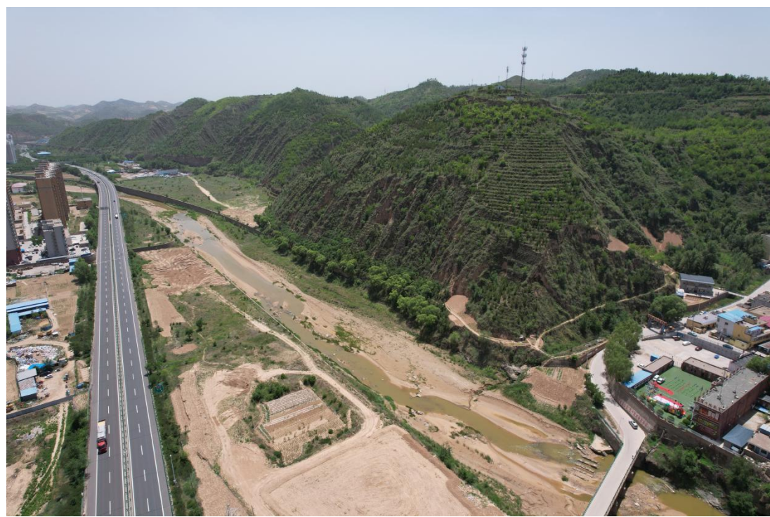
杜家沟第五小学段河道现状
