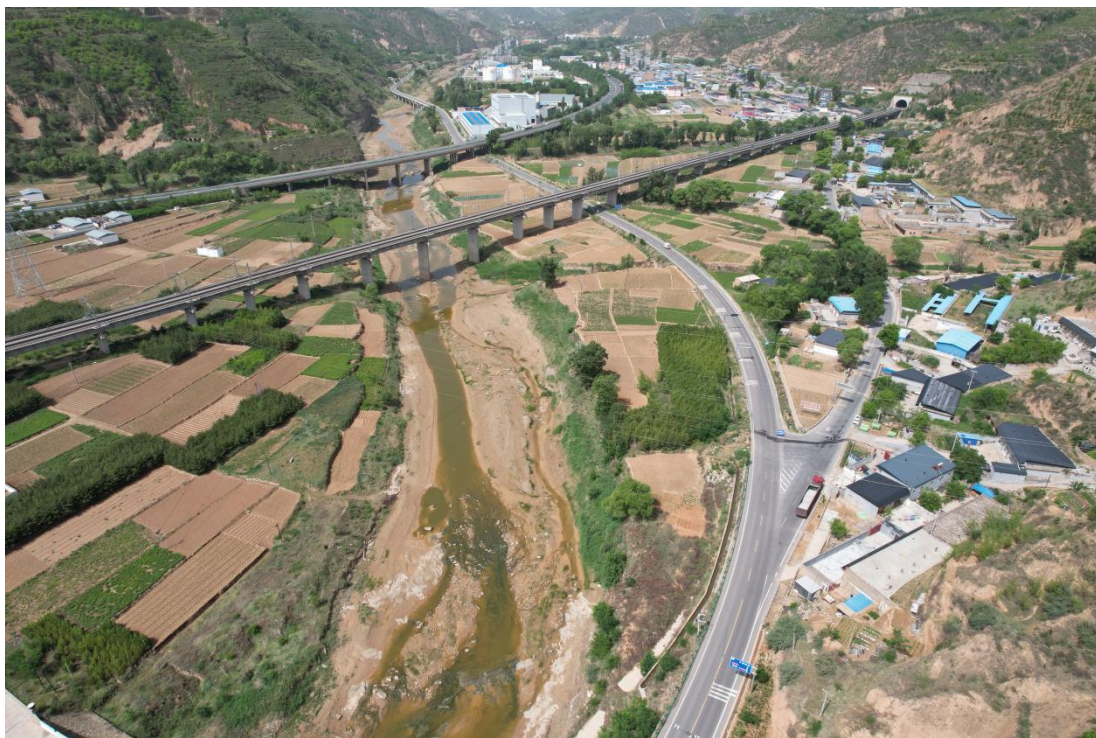
梁渠村段河道现状
